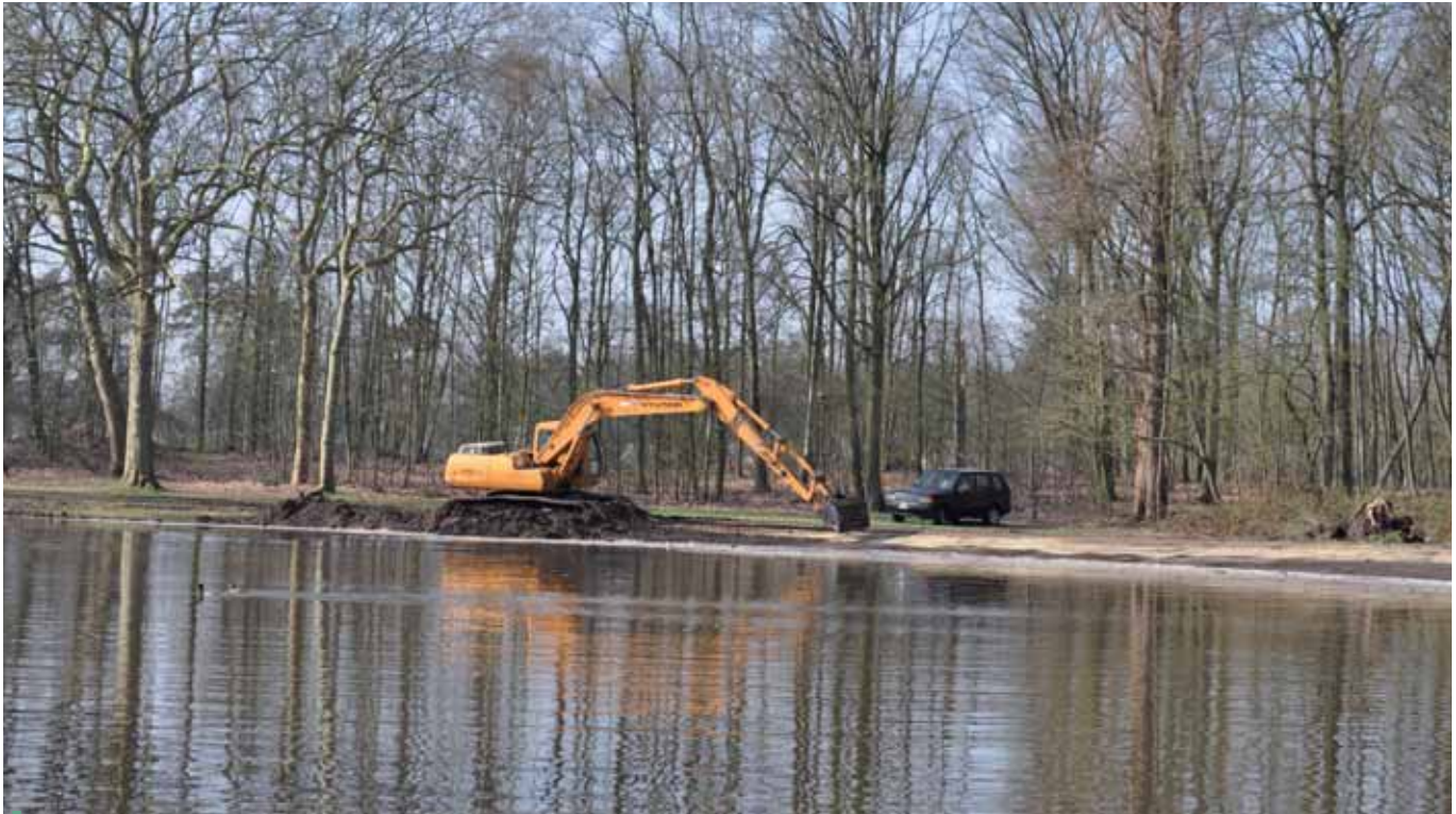
LIFE+parkvijver – travaux à Hasselt.
